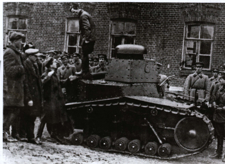
Изучение танка МС-1, снимок 1930 года. Это машина выпуска 1928 года с шестигранной башней без кормовой ниши.
